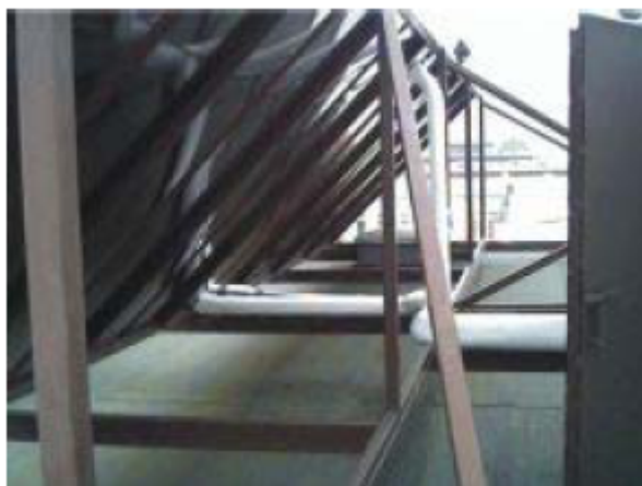
Konstrukcja stalowa po wzmocnieniu
