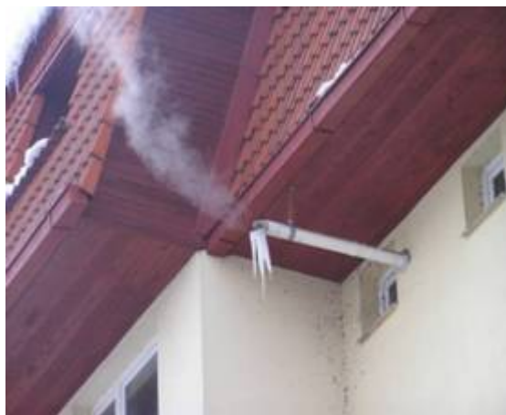
Rys.3 Tworzenie się korków lodowych w warunkach zimowych
