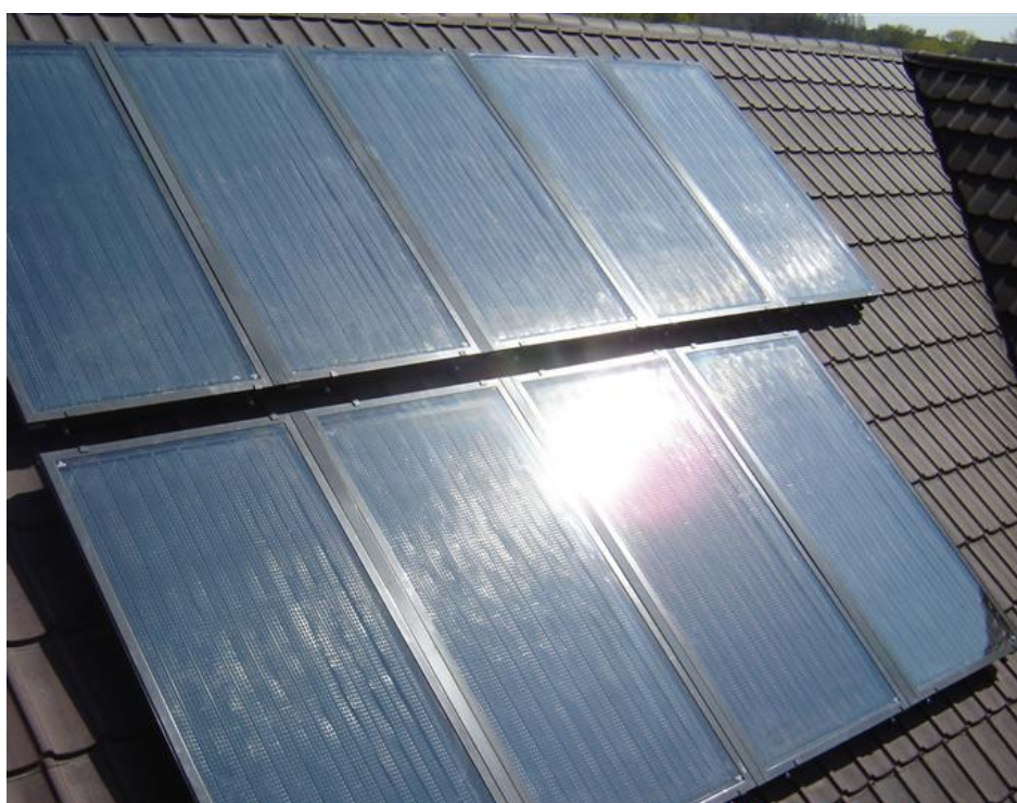
Fot. Kolektory słoneczne Hewalex KS2000 SP / SLP z absorberami pokrywanymi czarnym chromem
