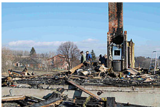
Skutki zapalenia się konstrukcji drewnianej domu. fot. Jotul
